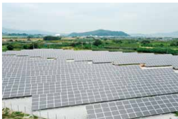
【村山浄化センター】
