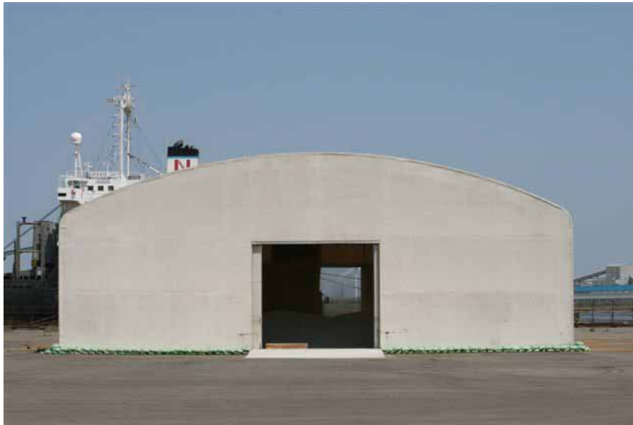
【仮設倉庫（仮設第1上屋）】
