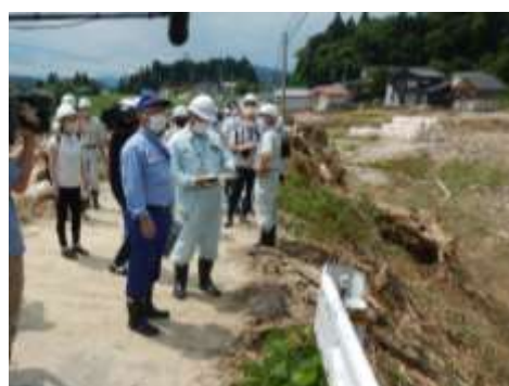
災害査定官による災害緊急調査
